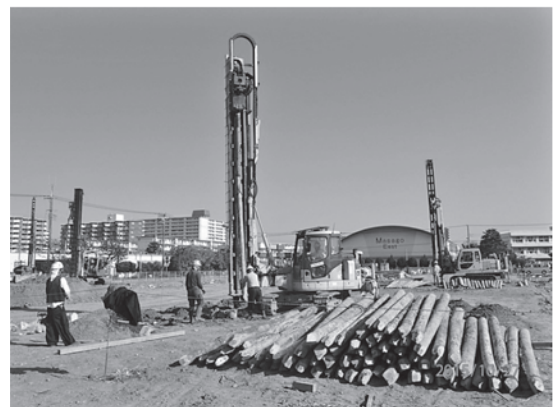
写真一 1 LP-LiC 工法の施工状況
