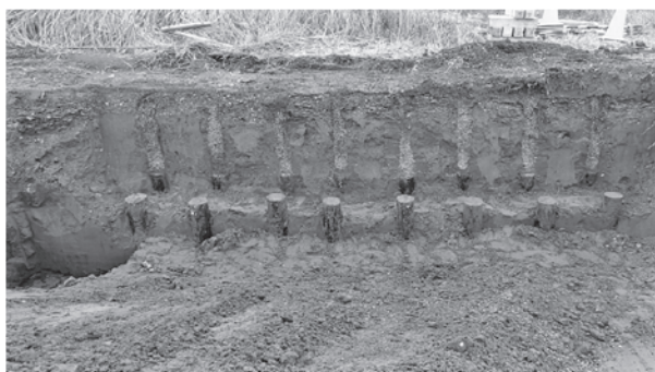
写真-2 丸太打設後10年経過した地盤断面の様子
