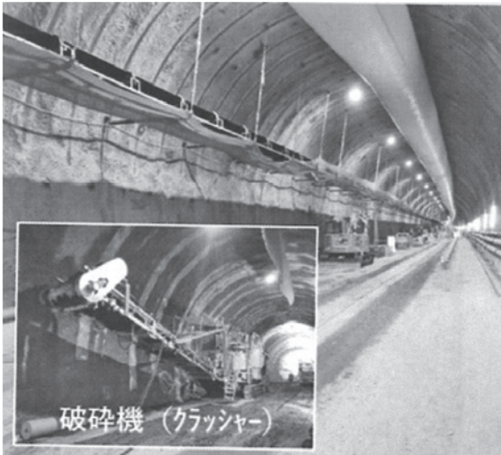
写真—2 連続ベルトコンベアと破碎機（天神トンネル作業所現場概要資料より）
