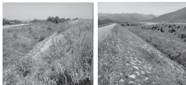
写真—1 石張護岸 (左 除草前、右 除草後)
