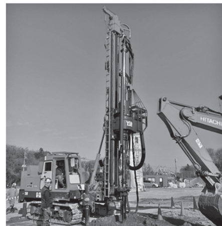
写真—2 N. ロールコラム工法施工機械
