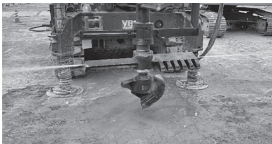
写真—1 水噴射テスト状況
