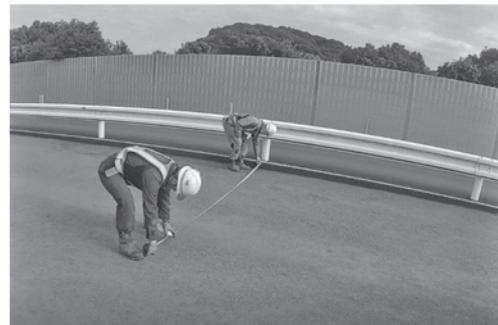
写真—1 路面マーキング作業（型枠配置用）
