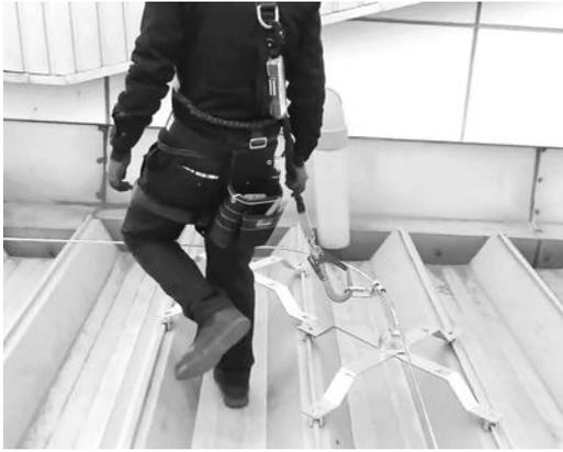
写真一 水平設置型システム
