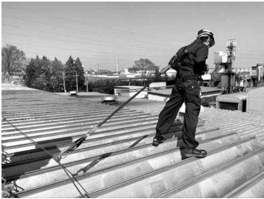
写真二 水平設置型システムによる「レストレイント」
