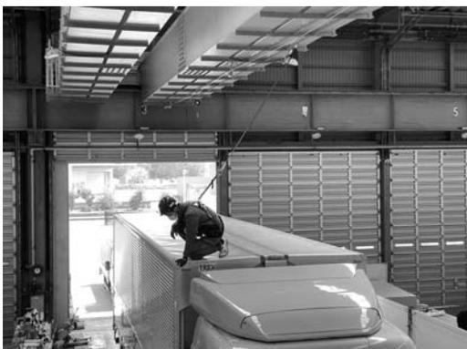
写真一七 倉庫の天井に設置した懸垂設置型システム
