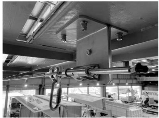
写真一八 屋内に設置した懸垂設置型システム（近接撮影）
