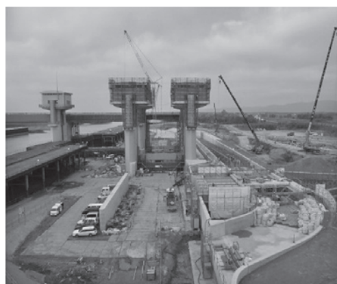
写真-1 工事実施状況
