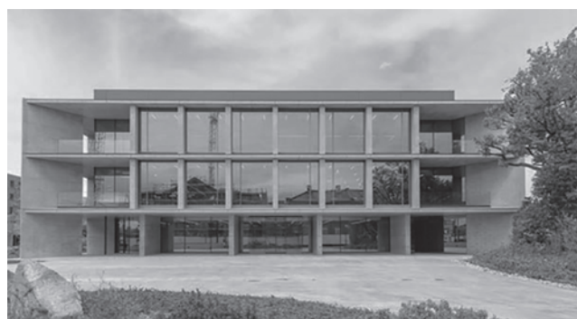
写真－1 北陸支店外観
