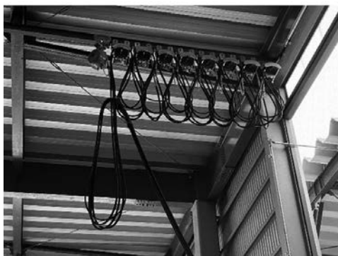
写真—8 電源ケーブルの配策
