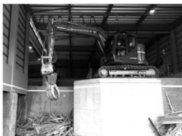
写真—7 13tクラスによる木材ハンドリング作業
