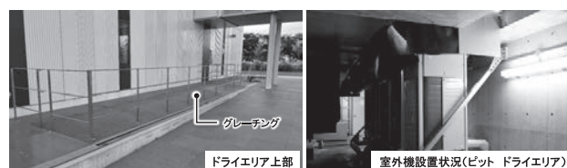
図—9 免震ピットへの室外機設置状況
