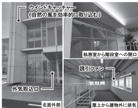
図一 11 各所の自然換気窓
