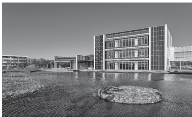
写真—1 エクスチェンジ棟 外観（南面）
