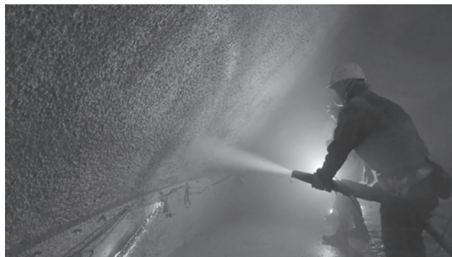
写真—3 吹き付けコンクリートによる躯体の構築
