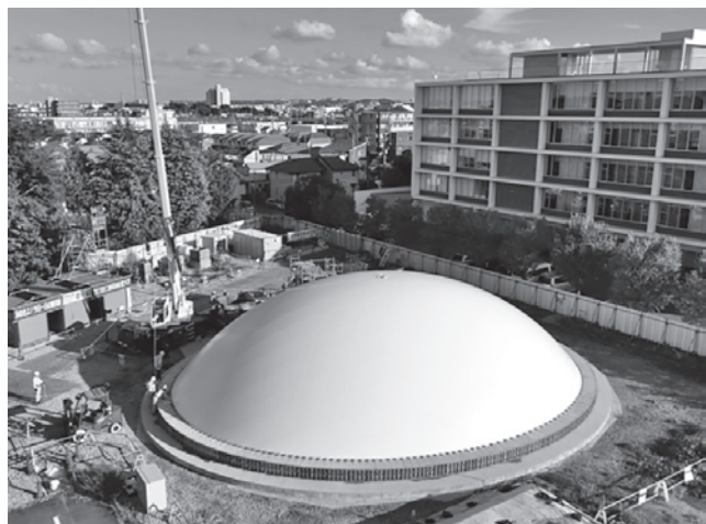
写真—1 ドーム建築物 (TBK ドーム：東京都調布市)
