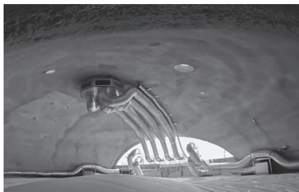
写真—5 炭酸化養生直前のドーム建築物（TBK ドーム）内部
