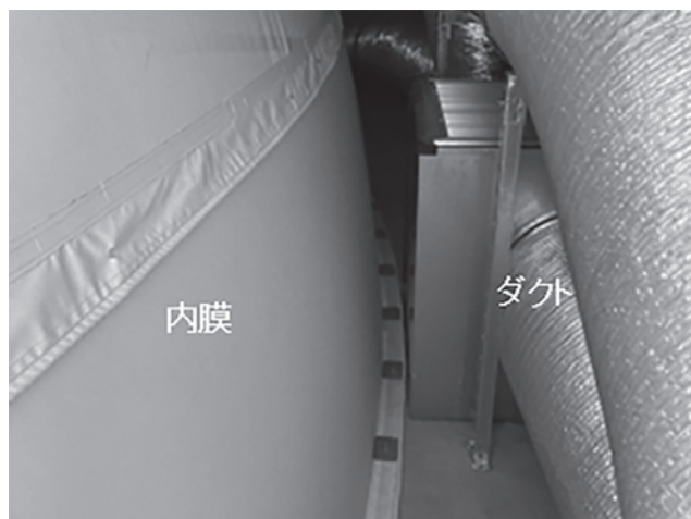
写真—6 ドーム建築物内部
