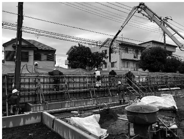
写真—3 コンクリートポンプを用いた打込み状況
