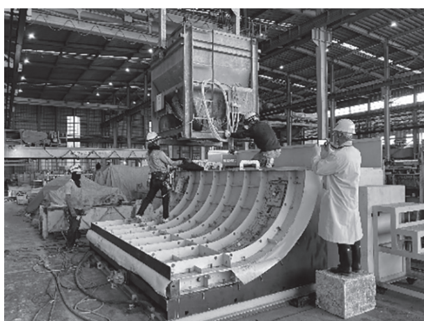
写真一七 PCカーテンウォールの製造状況②
