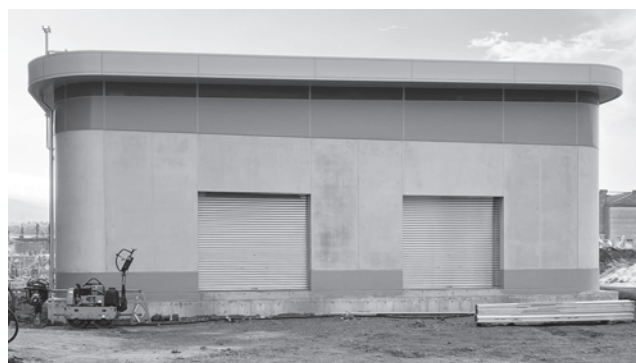
写真一八 本コンクリートによるPCカーテンウォールを適用した建物の外観
