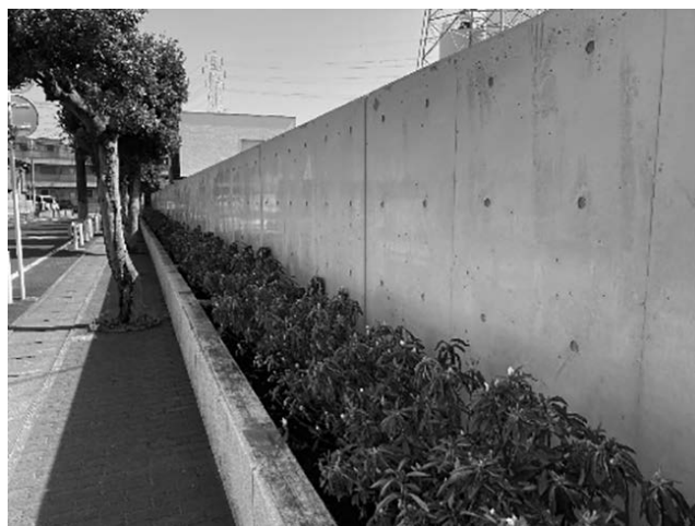
写真—4 外壁の仕上がり状況
