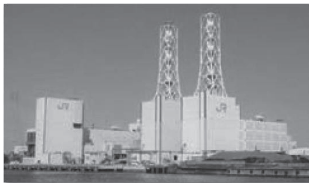
写真—2 川崎火力発電所
