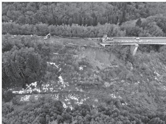
図一 3 沢埋めの高盛土被災（能登大橋南側）
