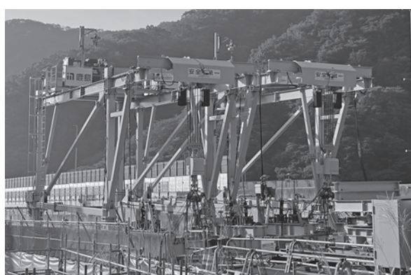
写真—2 既設床版の撤去機
