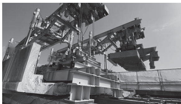
写真—7 既設床版の撤去状況（奥畑川橋）
