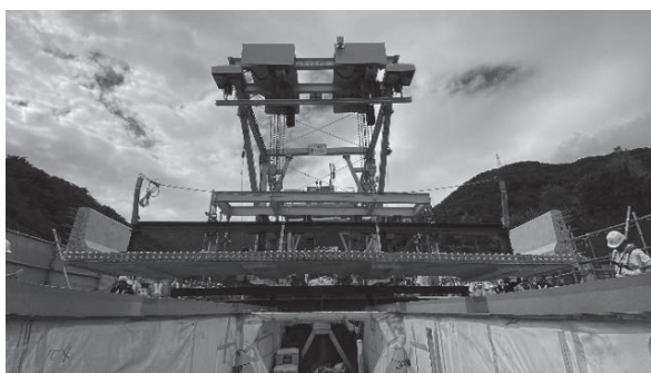
写真—6 新設床版の架設状況（阿能川橋）
