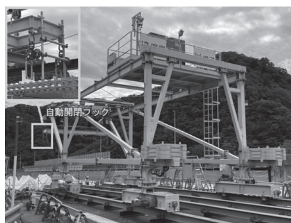
写真—3 新設床版の架設機
