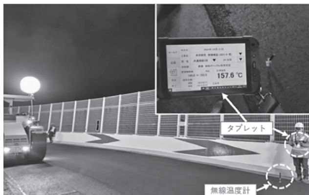
図-5 転圧温度計測状況
