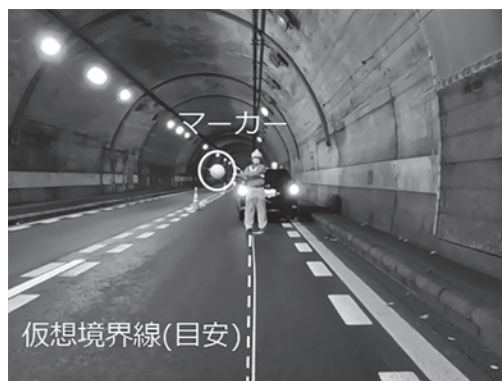
(c) 供用トンネル撮影画像
