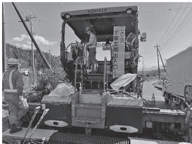
写真—9 現場における遠隔操作状況
