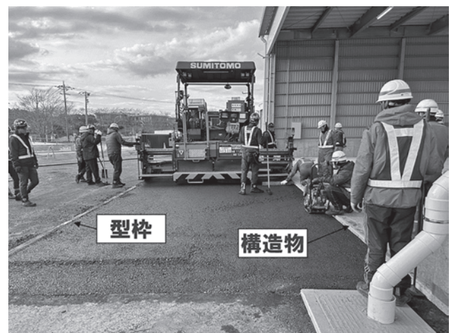
写真—3 試験施工②
