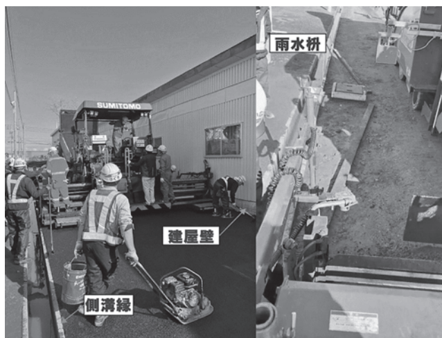
写真—2 試験施工①
