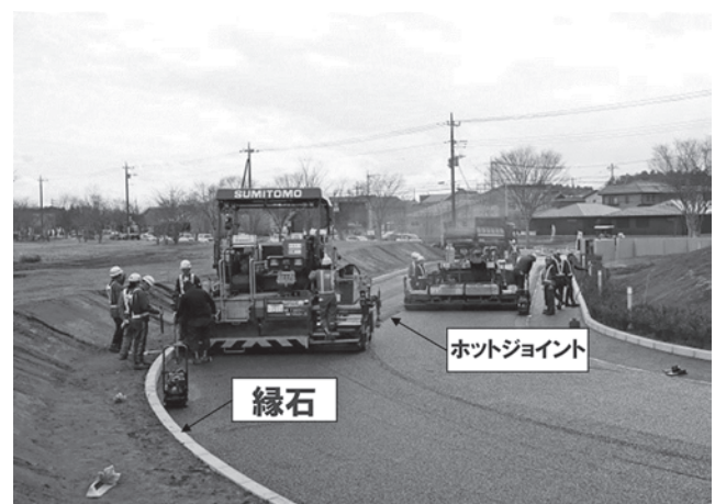
写真—4 試験施工③
