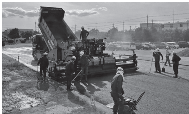
写真—1 舗装現場
