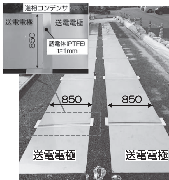
写真—6 定在波対策を施した送電電極の敷設
