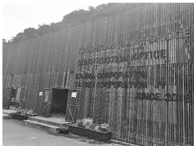
写真—6 現場事務所外観
