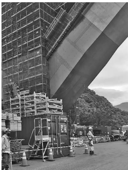
写真—5 外鋼殻構造部
