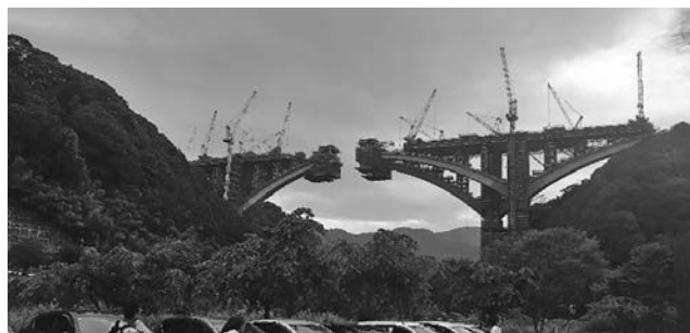
写真—2 近づく中央径間の移動作業車
