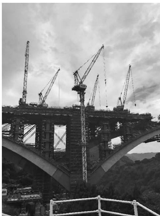
写真—4 アーチ根本のスプリング部：外鋼殻構造
