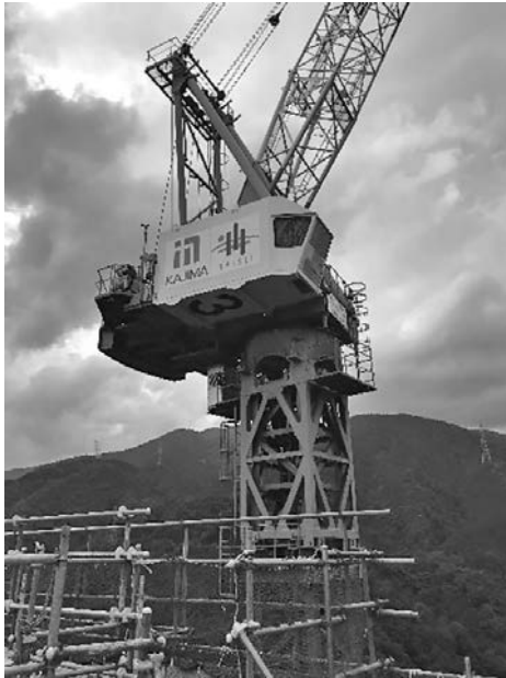
写真—8 タワークレーン
