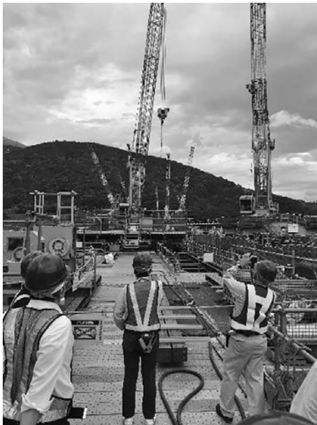
写真—9 運搬台車とトラバークレーン
