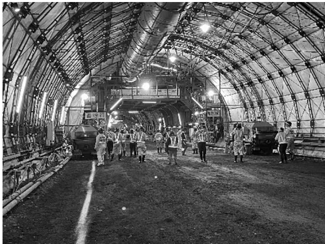
写真-7 セントル全景
