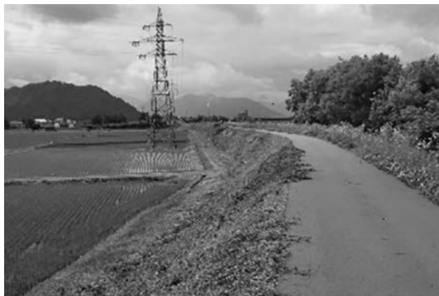
写真—1 急傾斜法面の例
