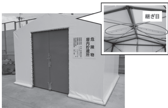
写真—4 危険物屋内貯蔵所の例
