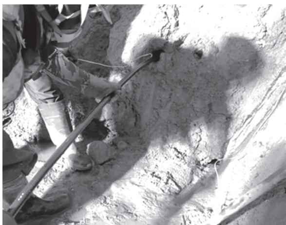
写真一 爆薬装填状況
