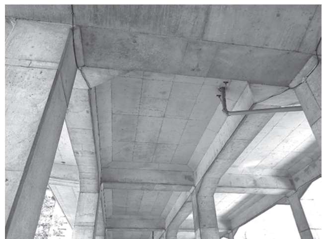
写真—2 点検に要する人員と費用を比較したラーメン高架橋の外観
