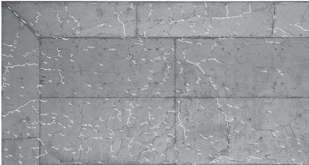
図一4 高架橋床版下面のひび割れ図
