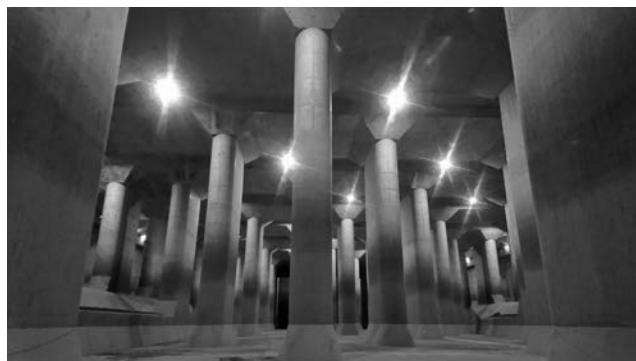
写真—1 首都圏外郭放水路 調圧水槽
