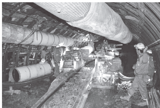
写真—3 掘進現場（HPより）
