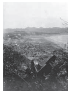
写真一3 鎌倉における被害(由比ヶ浜方面を望む) ※7
