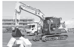
写真-20 遠隔操作によるガレキ移動
