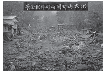
写真一1 伊勢原市大山町開山町の土石流被害 ※4
