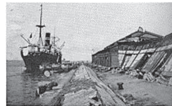
写真一2 横浜港第六岸壁の被害 ※6
