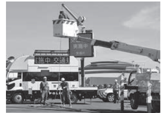
写真-23 倒壊電柱・電線の除去
