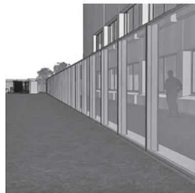
図一九 ガラススクリーン止水壁
