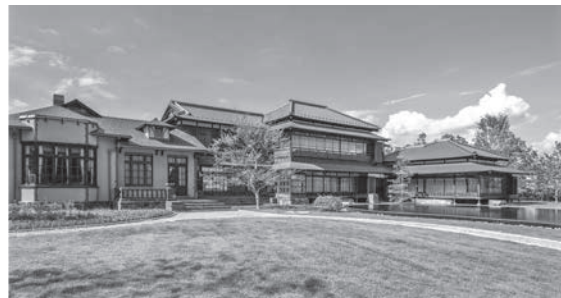
写真-1 江東区潮見へ再構築後の旧渋沢邸外観
