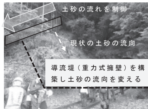
図一七 導流堤の設置
