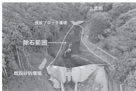
写真—9 既設砂防堰堤除石完了
