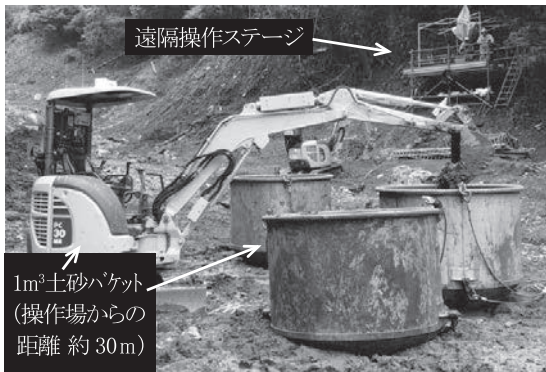
写真一四 遠隔操作バックホウ (0.1m³ 級)
