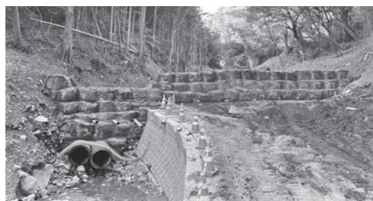
写真一7 仮設堰堤工(ネットロール土のう工)
