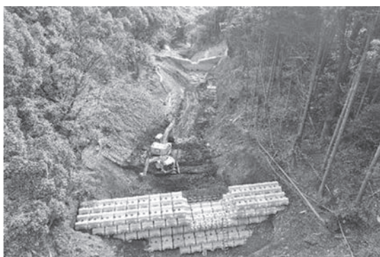
写真—8 仮設堰堤工（仮設ブロック堰堤工）
