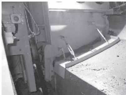
(d) 端部コンクリート打設
