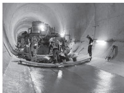
(h) コンクリート表面仕上げ
