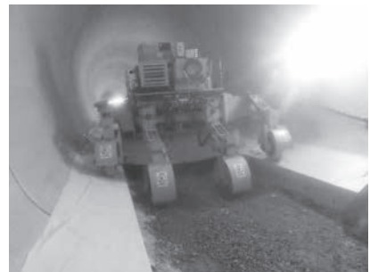
(f) 中央部コンクリート打設
