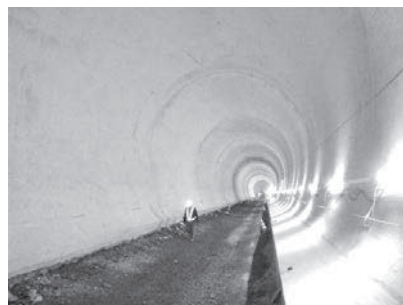
(e) 端部コンクリート打設完了
