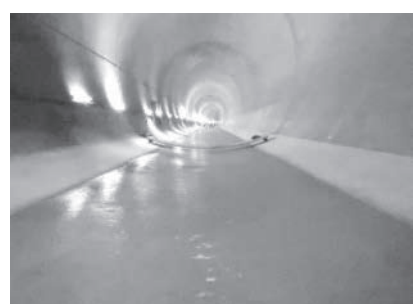
(i) コンクリート打設完了
