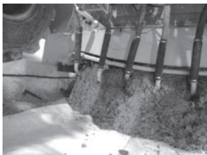
(g) コンクリート打設状況
