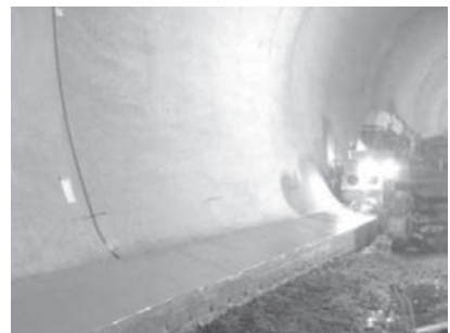
(c) 端部コンクリート打設
