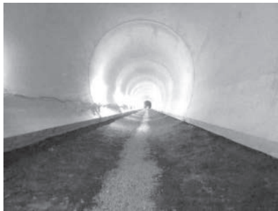
(a) 掘削・床付け
