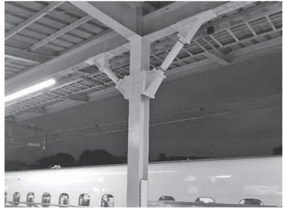
写真-1 補強箇所（柱梁接合部）
