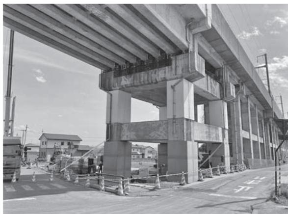
写真—5 鋼板巻き耐震補強完了
