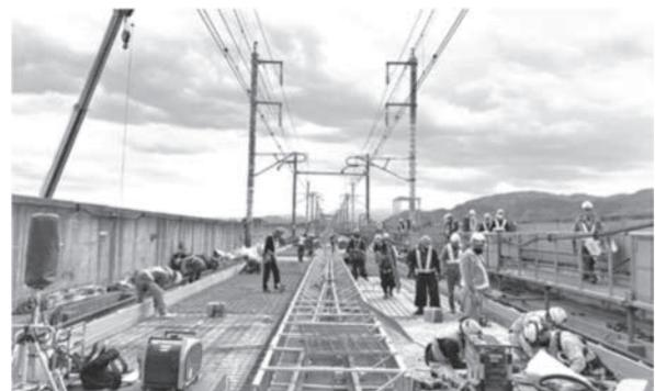
写真—6 路盤コンクリート施工状況
