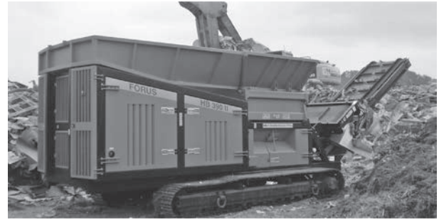
写真四 災害可燃性廃棄物の破碎減容作業
