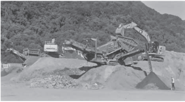
写真一 災害土砂選別及び分別作業
