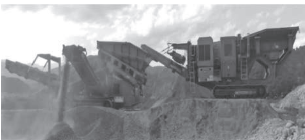
写真二 災害ガレキ破碎再資源作業
