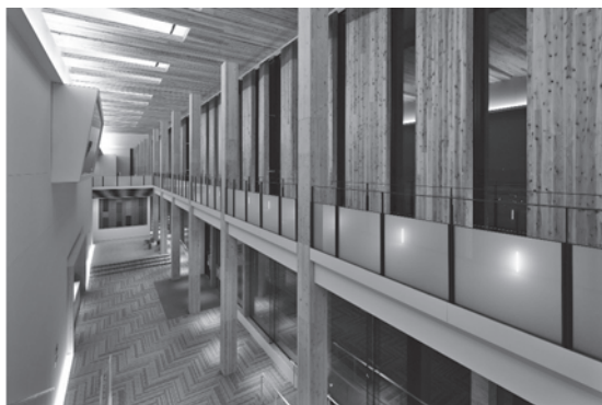
写真—4 準耐火鋼管柱の実施適用事例
