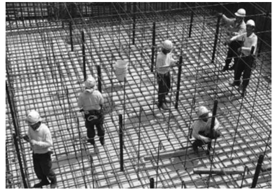
写真—1 生産現場における鉄筋工事の状況
