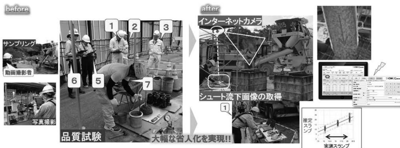
図一7 画像解析によるスランプ全量確認
