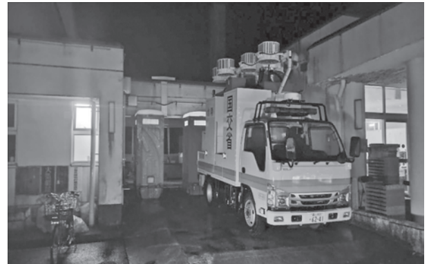
写真一〇 旧日本小学校への電源供給
