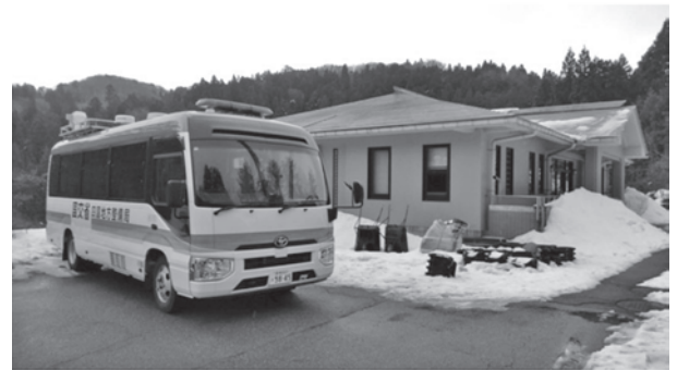
写真一八 地原浄水場（珠洲市）
