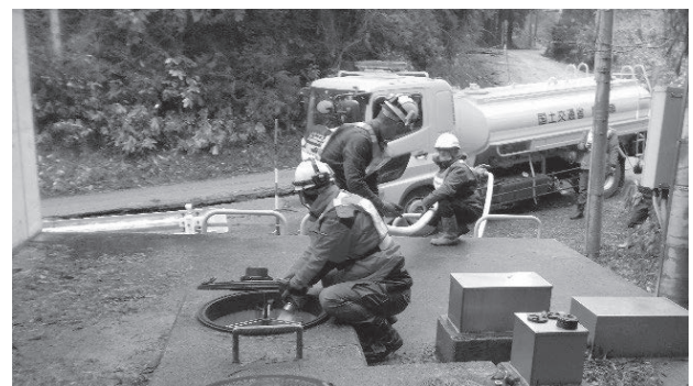
輪島市 清土ポンプ場 配水管漏水調査
