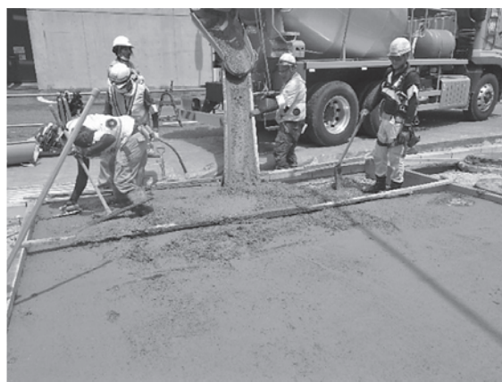
写真-7 本工法の打込み
