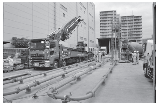
写真一 1 圧送試験配管組立状況
