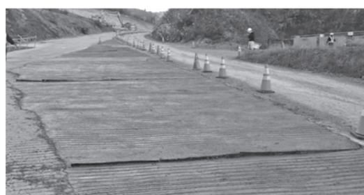
写真—3 仕上り状況（事例1）
