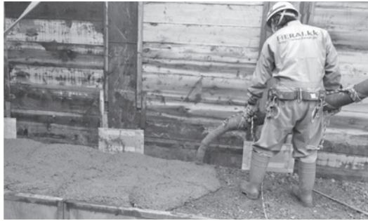
写真—4 コンクリート打込み状況（事例2）
