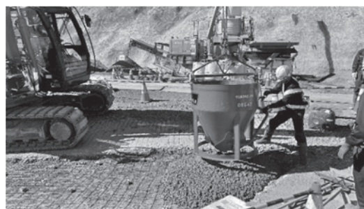
写真—2 コンクリート打込み状況（事例1）
