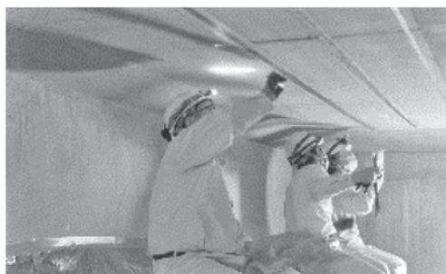
写真—6 テープ式陽極材貼り付け
