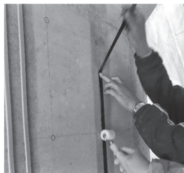
写真一1 テープ式陽極材の設置状況
