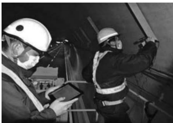
写真—6 ハンマーの打撃の結果からボルトやナットのゆるみの有無を把握する装置の例
