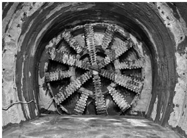
写真—3 岩塊撤去完了
