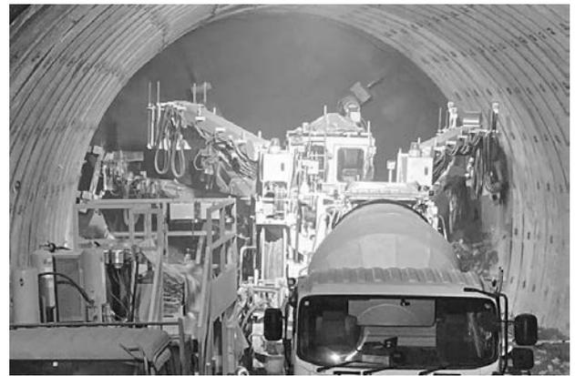
写真—4 2ノズル吹付機の自動化
