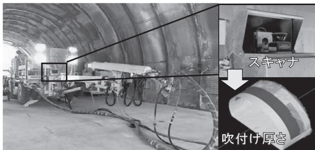
図—2 吹付機搭載型の計測システム
