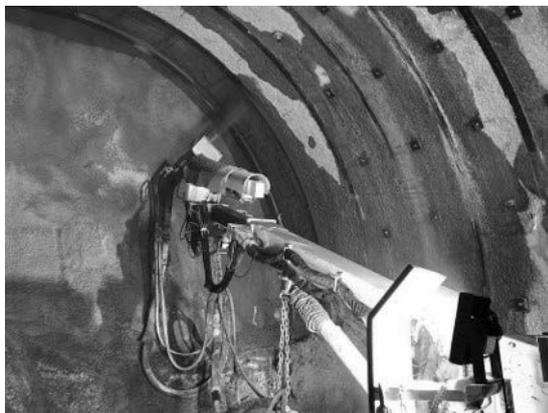
写真—3 支保工背面部への吹付け
