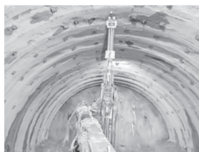
(f) ボルト挿入状況
