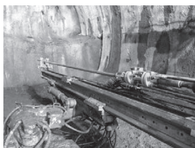
(a) ボルト・座金セット状況
