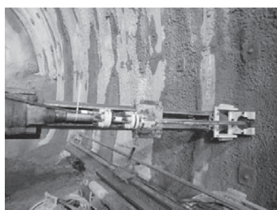
(g) ボルト挿入・座金設置状況
