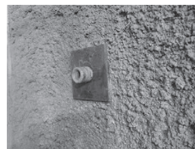
(i) 打設完了
