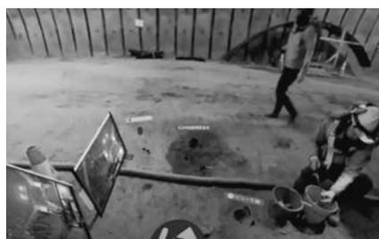
写真五 岩片のハンマー打撃音の確認
