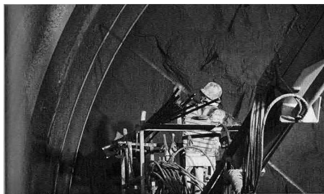
写真-1 モルタル注入する作業員 1)
