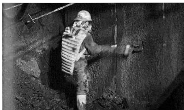
写真—2 ロックボルト打設 1)
