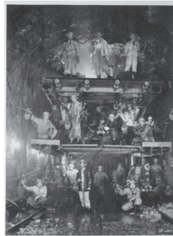
写真—6 新清水トンネル 11 ブームガントリージャンボ（湯檜曾工区）
